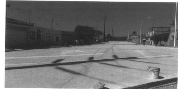
CONSTRUCCIÓN DE VIALIDAD EN COAHUILA COL. MORGA
