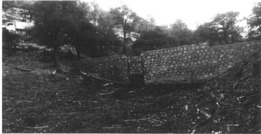
REHABILITACIÓN DE PRESA
