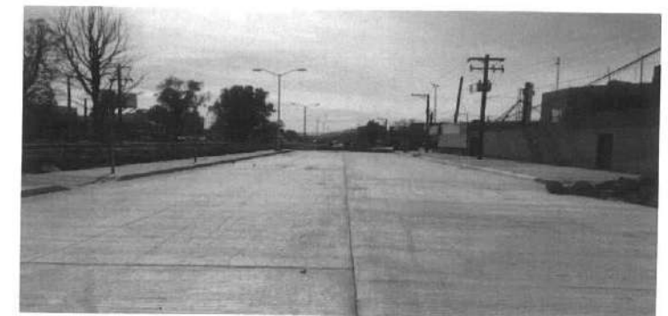
CONSTRUCCIÓN DE VIALIDAD EN PUERTO ENSENADA COL. MORGA
