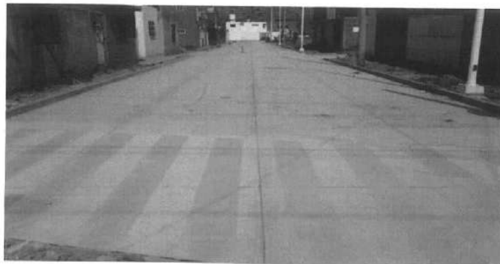
CONSTRUCCIÓN DE VIALIDAD EN MINA MAGISTRAL DEL ORO FRACC. ACEREROS
