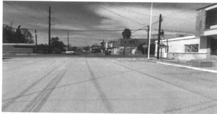
CONSTRUCCIÓN DE VIALIDAD EN CALLE OAXACA COL. MORGA
